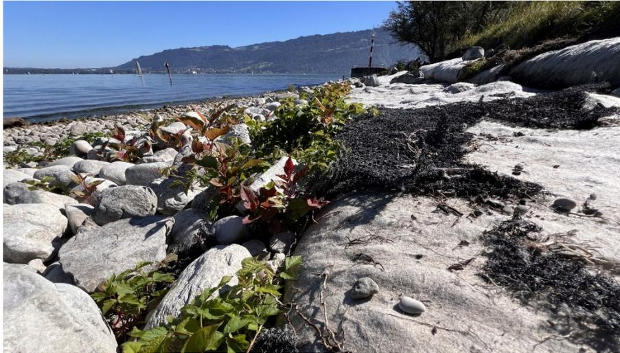
Abb. 118: Auch an der Böschung des Jachthafens wurden Vlies und Erosionsschutzmatte freigespült. 7. September 2024.
