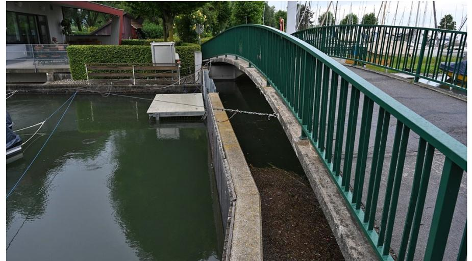
Abb. 25: Die Suppersbachmündung wurde abgesperrt und mit einer Pumpe versehen, um den Wasserstand landseitig niedrig zu halten. 12. Juni 2024
