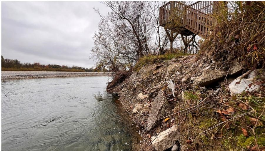
Abb. 129: Erosion am rechten Achufer durch mehrere Hochwässer, unter anderem auch im Bereich der Beobachtungsplattform, wo abgelagerter Bauschutt freigespült wurde. Da sich die Plattform nahe am Ufer befindet, sollte die weitere Entwicklung sorgfältig beobachtet werden. 10. November 2024.
